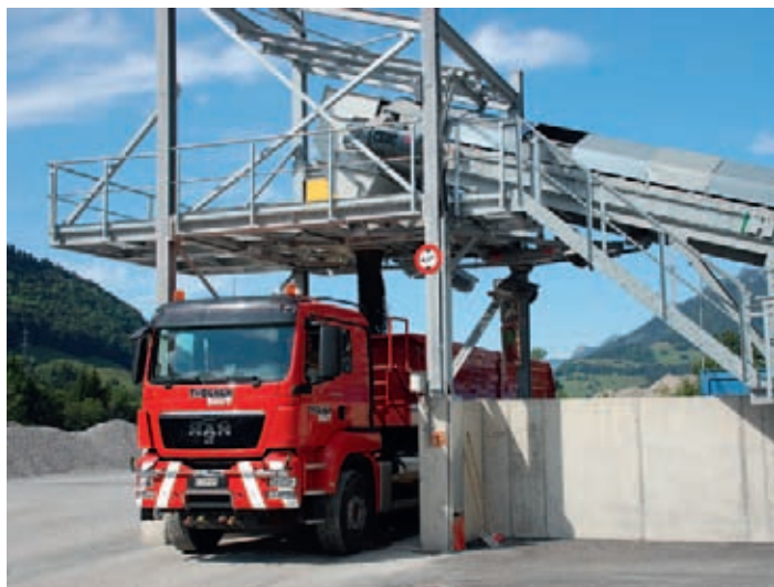
Über die Dosieranlage werden die Materialauslieferungen für den Kiesverlad vollautomatisch gesteuert
