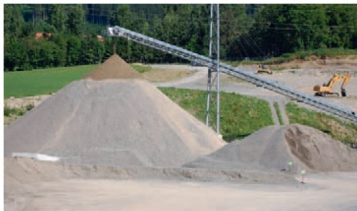
Das Material gelangt über die Förderbandanlage auf eine Zwischendeponie und von dort auf ein Abzugband mit einer Leistung von 150 t/h. Dadurch ist eine Reservebildung des Rohmaterials für mehrere Tage möglich, was zur hohen Produktionsflexibilität beiträgt
