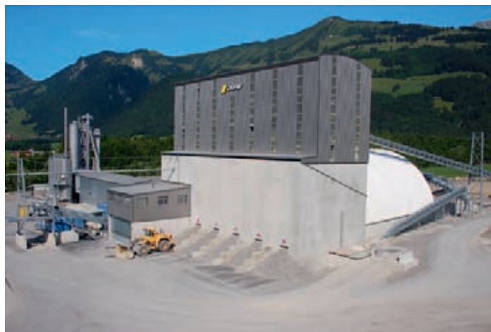
Übersicht über die Produktionshalle mit 35 m Länge und 34 m Höhe des Werks von JPF. Dahinter das aus dem Jahre 2005 stammende Belagswerk
