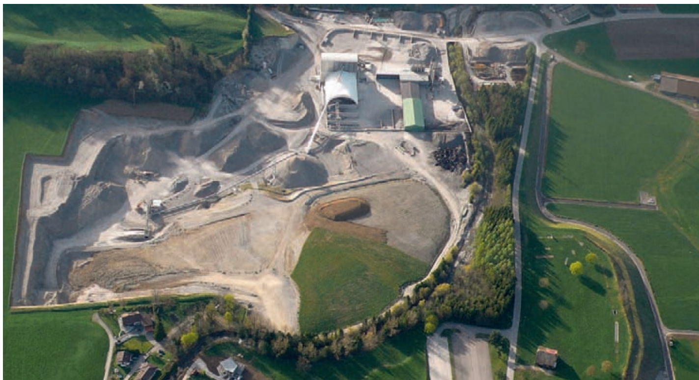
A la gravière de la Tana à Grandvillar FR le groupe JPF a investi près de 11 mio de francs dans le remplacement du système d'extraction. Photo: JPF
