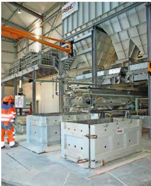
Herstück der Steinkorb-Abfüllanlage ist der im Hallenboden eingelassene Drehrütteltisch. Dieser ist mit zwei Füllkörben ausgestattet, die über ein fahr- und hubverstellbares Förderband beschickt werden
