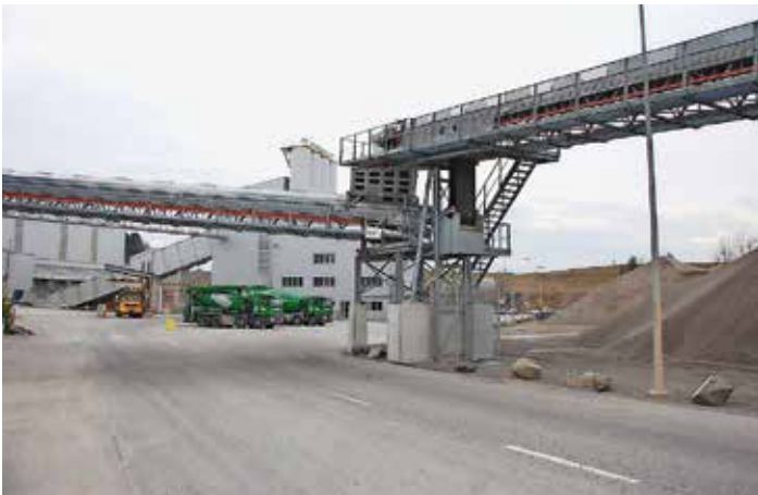
Zur Umstellung des Wandkiestransports vom Abbaugelände ins Kies- und Betonwerk der Risi AG in Cham auf eine umweltfreundliche Transportart ist eine mehrteilige Bandförderanlage von 824 m Gesamtlänge eingerichtet worden. Fotos: ASE/ICM
