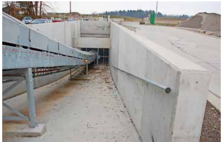
Mit der neuen Bandförderanlage kann auf den Einsatz von knickgelenkten Dumpern für den Wandkiestransport verzichtet werden. Zudem entfallen die zahlreichen Überquerungen der Knonauerstrasse mit Transportfahrzeugen
