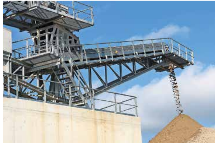
Zur Beschickung der Vorbrecherei und zur Anlage von Reservedepots ist eine 14 m hohe Übergabe auf das Schwenkband von 15 m Länge errichtet worden
