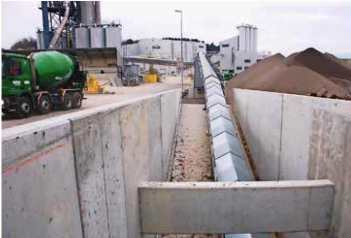
Das Trasse der Kantonsstrasse ist ohne Verkehrsunterbruch mit einem 60 m langen Förderbandtunnel unterquert worden und nimmt ein 211 m langes Tunnelband auf
