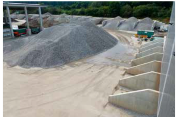
Vorratsbunker mit aufbereitetem Material Storage bunker with prepared material
